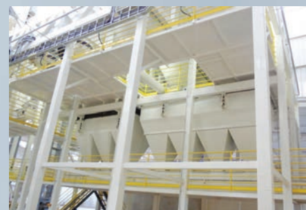
Caçamba de Pesagem / Weighing Bucket / Tolva Pesaje
